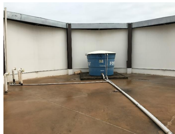
Caixa D'água Geral 5000L - Cobertura - Bloco 01
