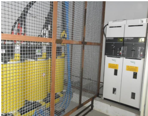
Equipamento de subestação de energia - Bloco 01
