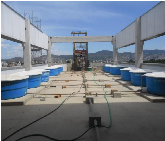
Caixa D'água 1500L - 12 Caixas - Bloco 03
