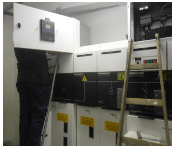
Equipamento de subestação de energia - Bloco 01
