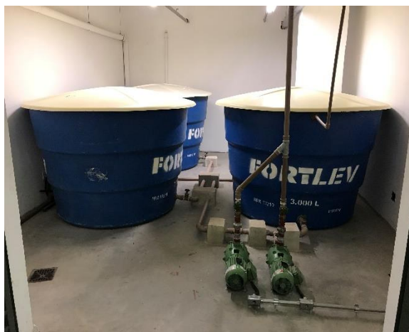
Caixa D'água 3000L - Subsolo - 3 Caixas
