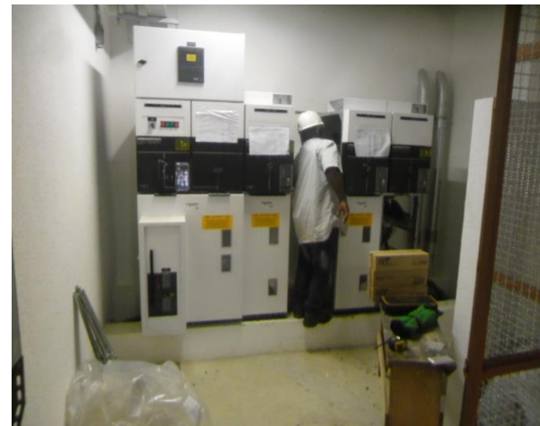
Equipamento de subestação de energia - Bloco 07
