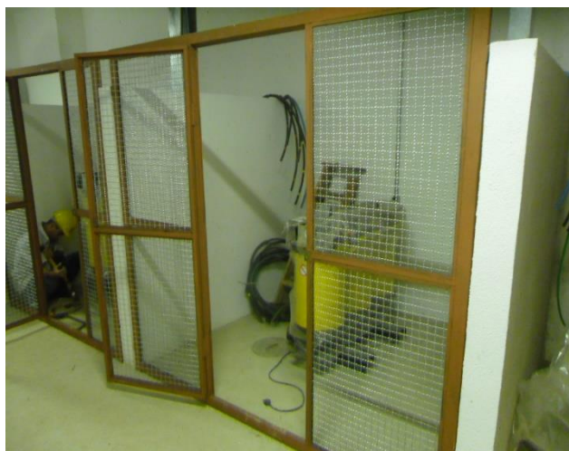
Equipamento de subestação de energia - Bloco 07
