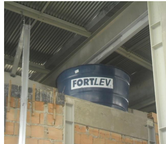
Caixa D'água 2000L - Bloco 07
