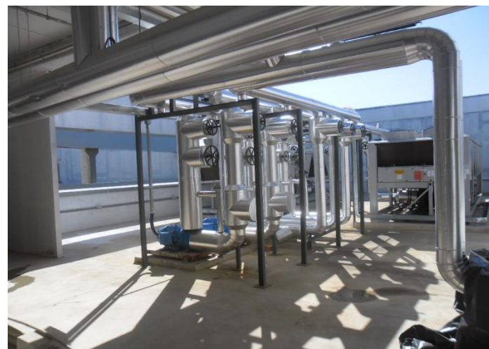
Ar Condicionado - Chiller
